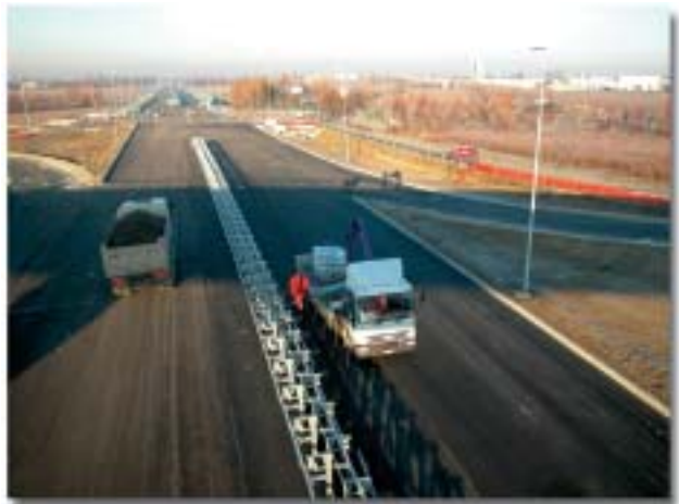
Dal ponte svincolo Altichiero verso Nord
