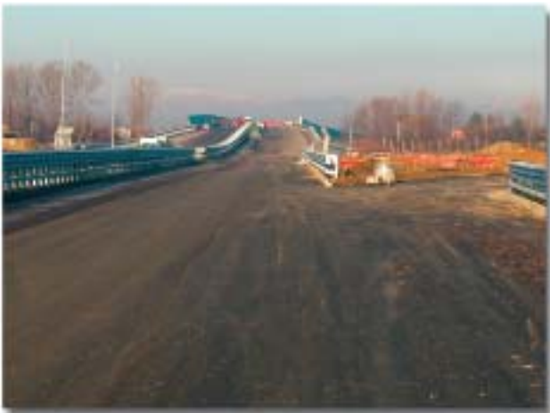
Ponte sul Brentella da Sud
