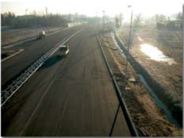
Dal ponte svincolo Altichiero verso Sud
