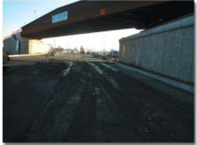
Ponte svincolo Nord
