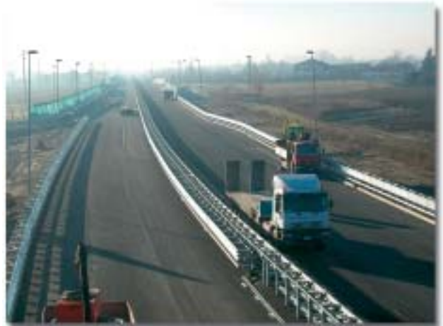
Dal ponte svincolo Nord, verso Sud
