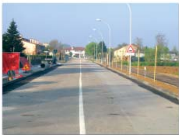
Ricostruzione dei marciapiede su Via Celso Basso
